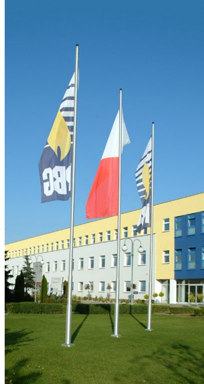
Budynek A w siedzibie PBG wykorzystuje kogenerację do wspomagania działania klimatyzacji w lecie (fot. Piotr Mierzwa)
